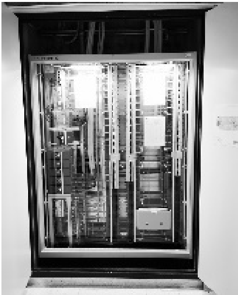
Bildungsanlage: ETH Zürich, Gebäude HPF Umbau Optiklabor Prof. Chu
